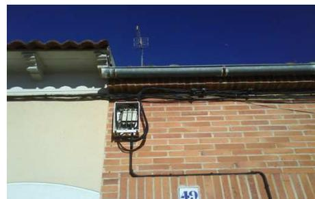
En la Figura 8.45, se aprecia en detalle el conexionado de una acometida trifásica mediante conectores de perforación simultánea a una red de distribución aérea, así como la CGP. **Fig. 8.45. Detalle de la conexión de una acometida aérea trifásica**
