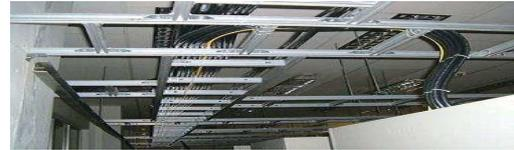
Fig. 8.10. Instalación de cables sobre bandeja de rejilla en las posiciones horizontal y vertical
